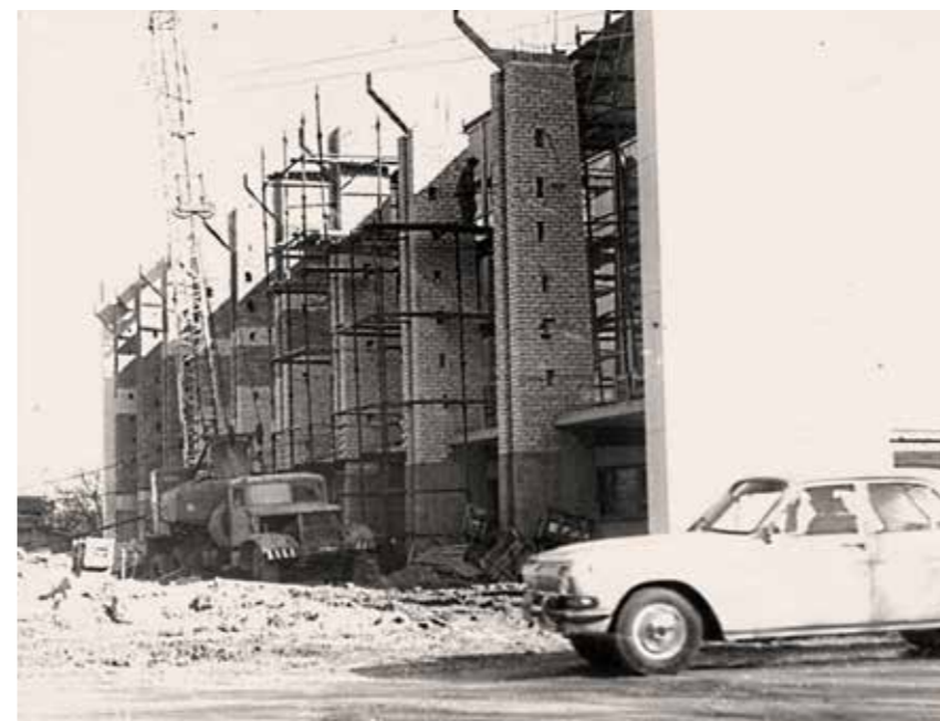
«Строительство Дворца спорта «Победа», вид с улицы Октябрьской. Фото из фондов Каневского районного историко-краеведческого музея»
