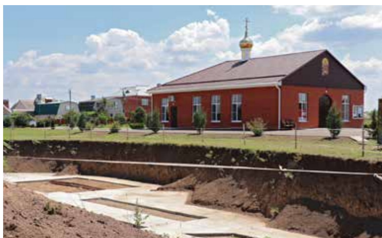
Строительство храма 40 мучеников Севастийских в микрорайоне Южном, 2019 г. Фото Елены Бутенко.
